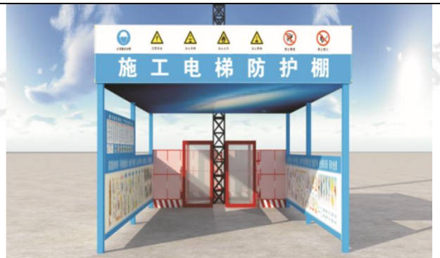
图 37 施工电梯防护棚
