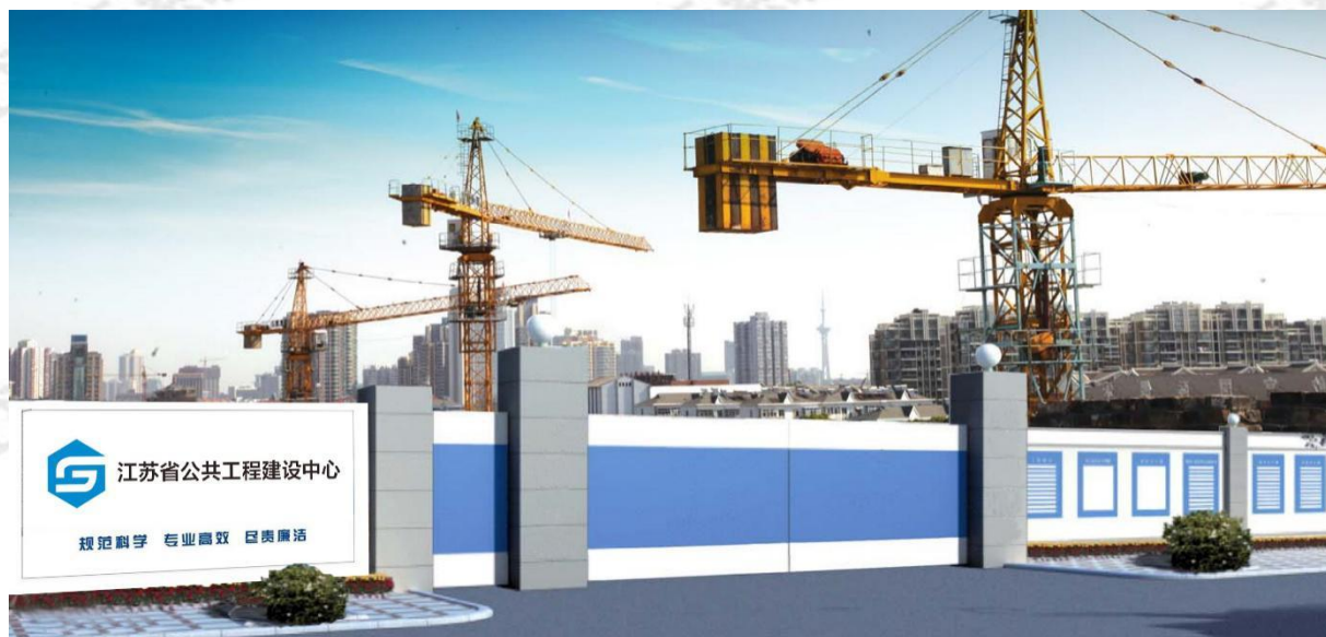
图 24 施工现场大门（无梁式）
