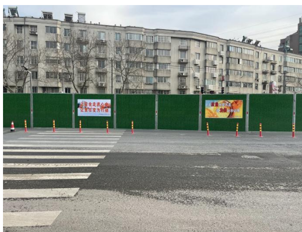
图二、封闭围挡实例图
