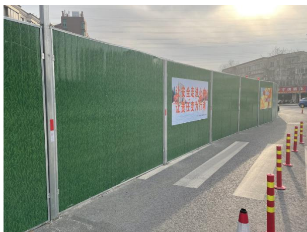
图一、封闭围挡实例图
